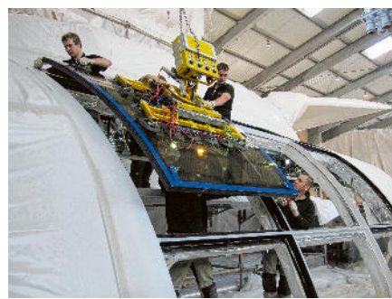
Beim Einbau der Spezialgläser ist höchste Präzision angesagt
