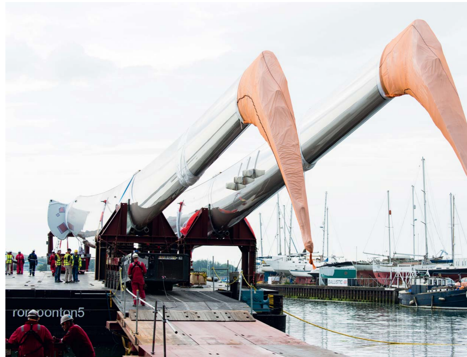
Auf diesem Bild gut zu erkennen: Die Masten weisen eine leichte Biegung nach vorn auf. Magma Structures aus Portsmouth entwickelte schließlich die freistehenden Masten – aus Kohlefaser – dem einzigen Material, das der Belastung würde standhalten können.
